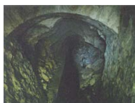
Cote 280: sortie maçonnée
