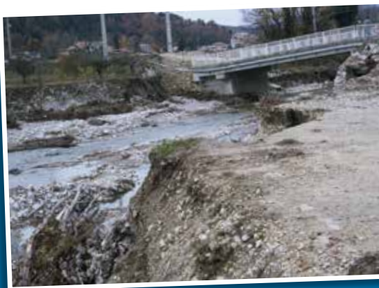
Dégâts suite à la crue du Lez de 1993 à Montjoux-La Paillette © SMBVL
