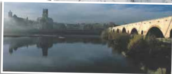
Vue en rive gauche du Pont de la ville de Pont-Saint-Esprit. 2006 ©P. Dechapiot extrait de «Le pont Saint-Esprit, prouesse médiévale»
