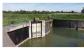
Station de pompage et martelières
